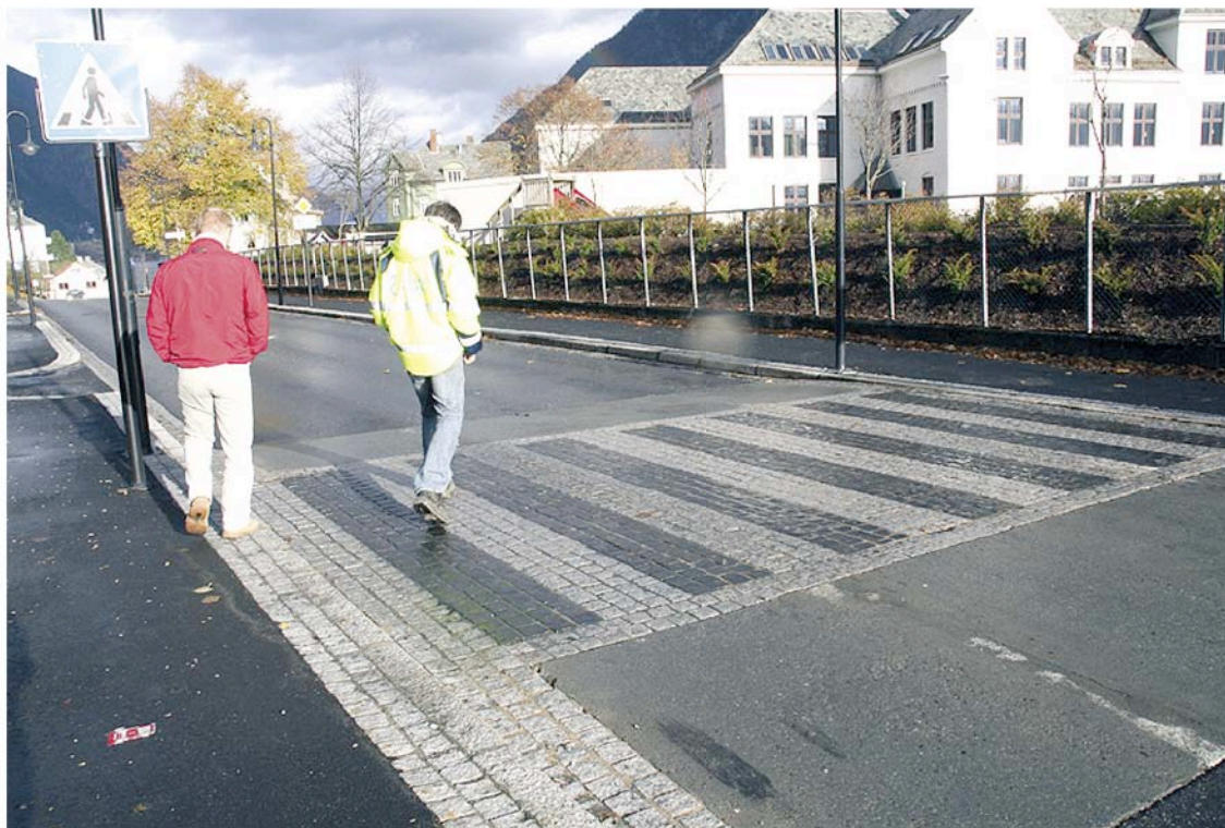
Befaring av gangfeltene etter ca. ett års bruk. Samtlige felt ble vurdert. Opheimsgata har stor gjennomgangstrafikk av busser og tyngre kjøretøy som bruker traséen på veien mellom Bergen og Oslo. Som det fremgår av bildene; Etter ett år har trafikken allerede påført samtlige av betongrampene for gangfeltene store skader.
