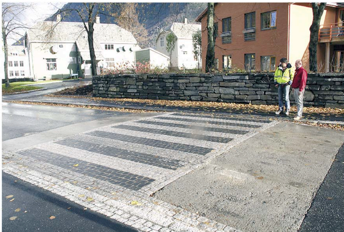
Befaring av gangfeltene etter ca. ett års bruk. Samtlige felt ble vurdert. Opheimsgata har stor gjennomgangstrafikk av busser og tyngre kjøretøy som bruker traséen på veien mellom Bergen og Oslo. Som det fremgår av bildene; Etter ett år har trafikken allerede påført samtlige av betongrampene for gangfeltene store skader.
