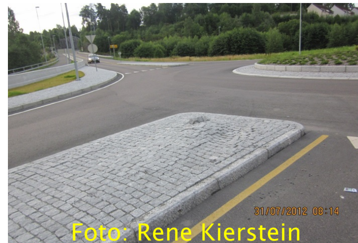
Deformasjon i steindekke etter belastning
