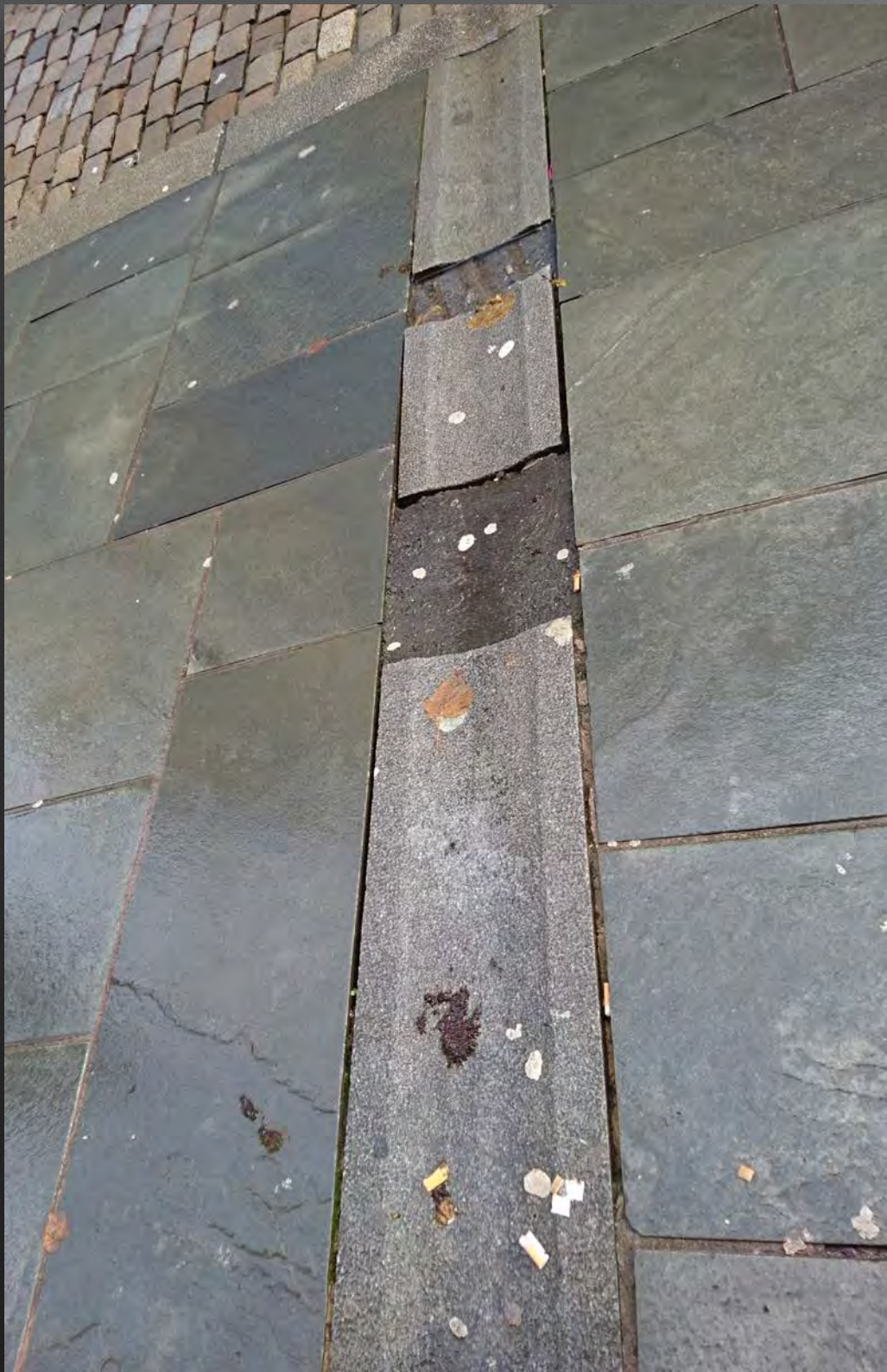
Skifer montert i jordfuktig betong med sementbasert fugemasse, med permeabel mørtel kunne frostspreng blitt unngått. Jordfuktig betong gir ikke heft og er kjent for å smuldre opp til sand over tid.
