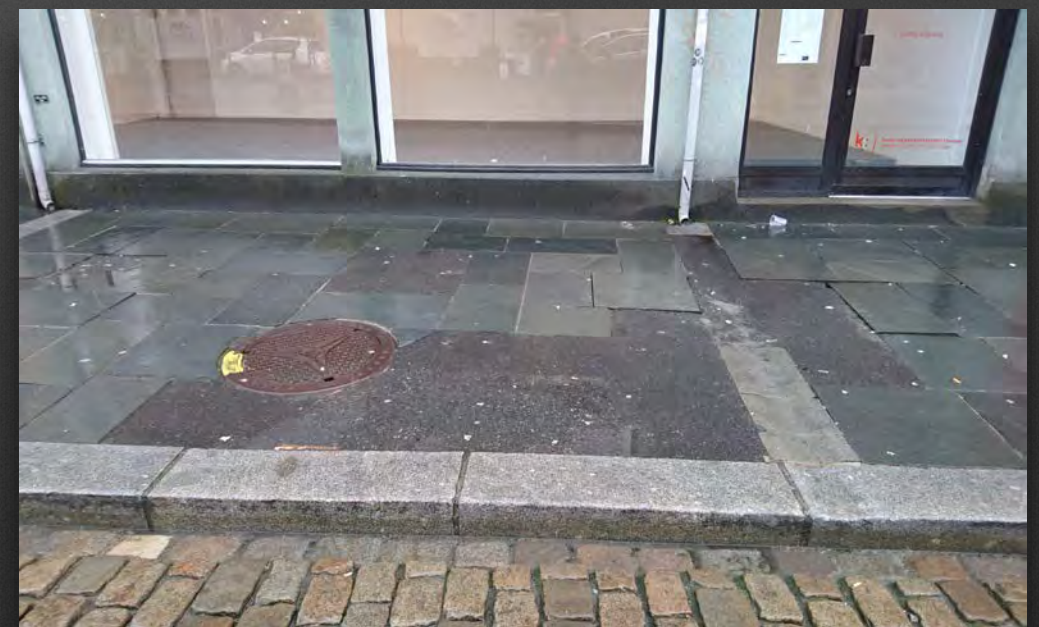
Skifer montert i jordfuktig betong med sementbasert fugemasse, med permeabel mørtel kunne frostspreng blitt unngått. Jordfuktig betong gir ikke heft og er kjent for å smuldre opp til sand over tid.
