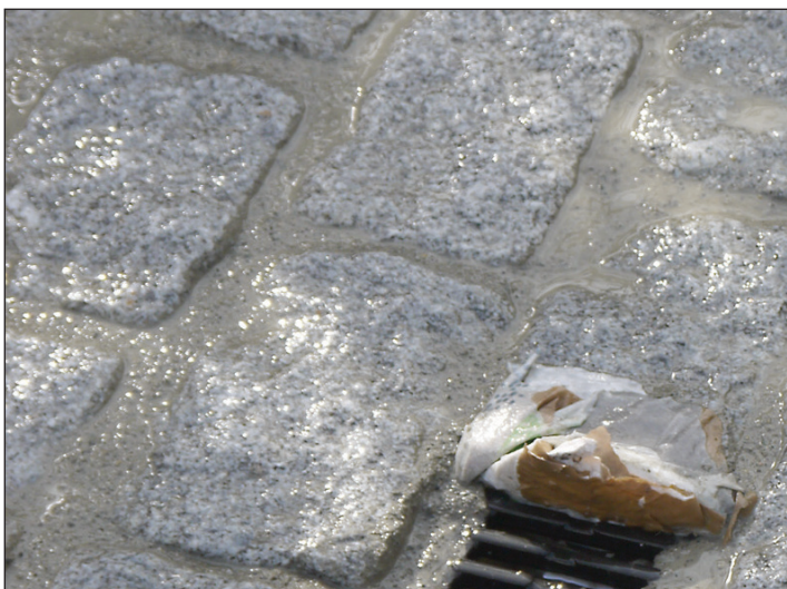
FERDIG! Etter ca. 20 minutter er naturFUG begynt å herde/sette seg. Belegget spyles deretter nøye på overflaten til den er ren.
