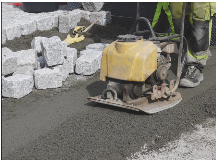
BÆRELAGET: Her benyttes naturSETTE-D i 10cm høyde. Komprimeres lett. Som man ser, kan bærelaget legges fortløpende i forkant av settelaget.
