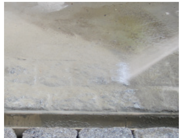
Etter ca. 20 min. spyles overskuddsmassen bort. BETO naturFUG gir naturlige, men sterke fuger. Se baksiden for nærbilde av ferdig, tørr fuge.
