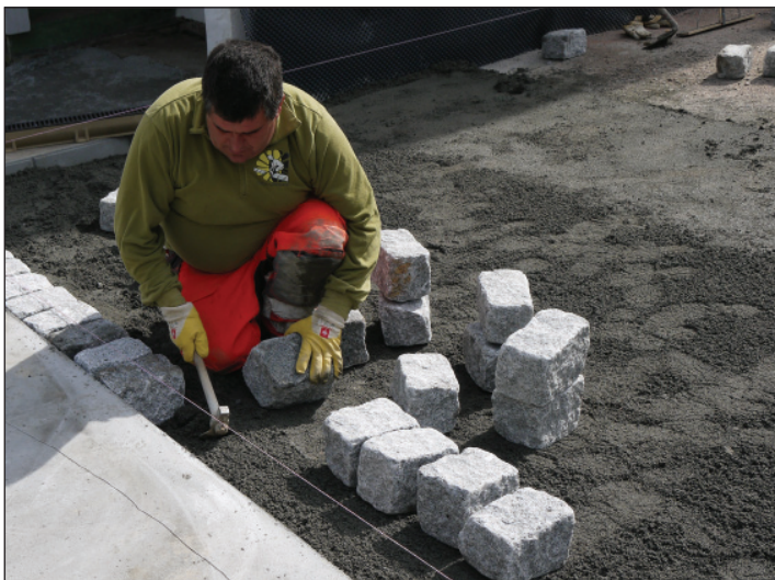
SETTELAGET: Steinsetteren i arbeid like etter at bærelaget er komprimert. Bærelag og settelag legges vått i vått. Vi ser bærelaget i bakgrunnen.
