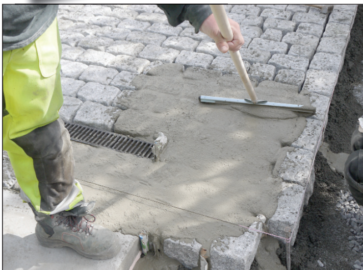
FUGEMASSEN: Enklere fuging får man ikke! Fugemassen er tyntflytende og helles ut over belegget. Det overskytende svabres ned i fugene.
