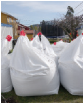
BigBag á 450kg. Tilpasset for bruk i 300L tvangsblender. To blendere gir kontinuitet.
