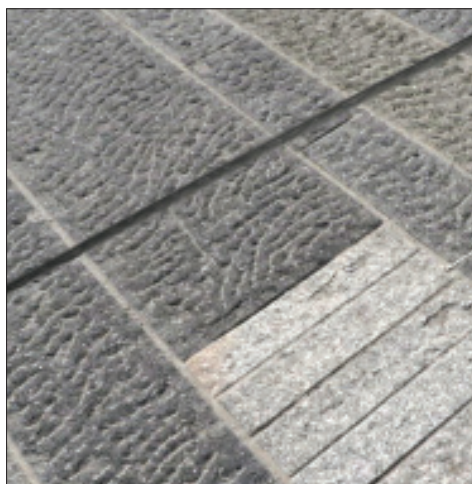
Ekspansjonsfuge. Korrekt lagt i rett linje gjennom belegget.
