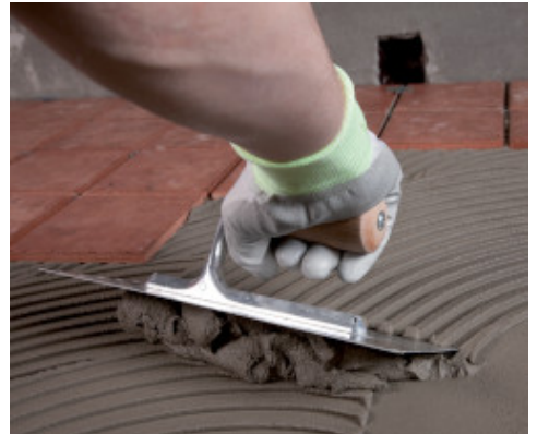
Påføring av Granirapid på terrasse vanntettet med Mapelastic Zero
