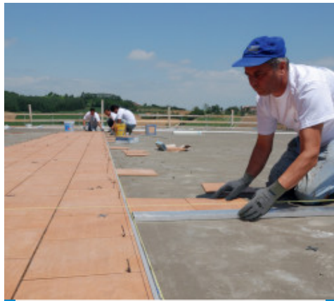
Flislegging med Kerabond + Isolastic
